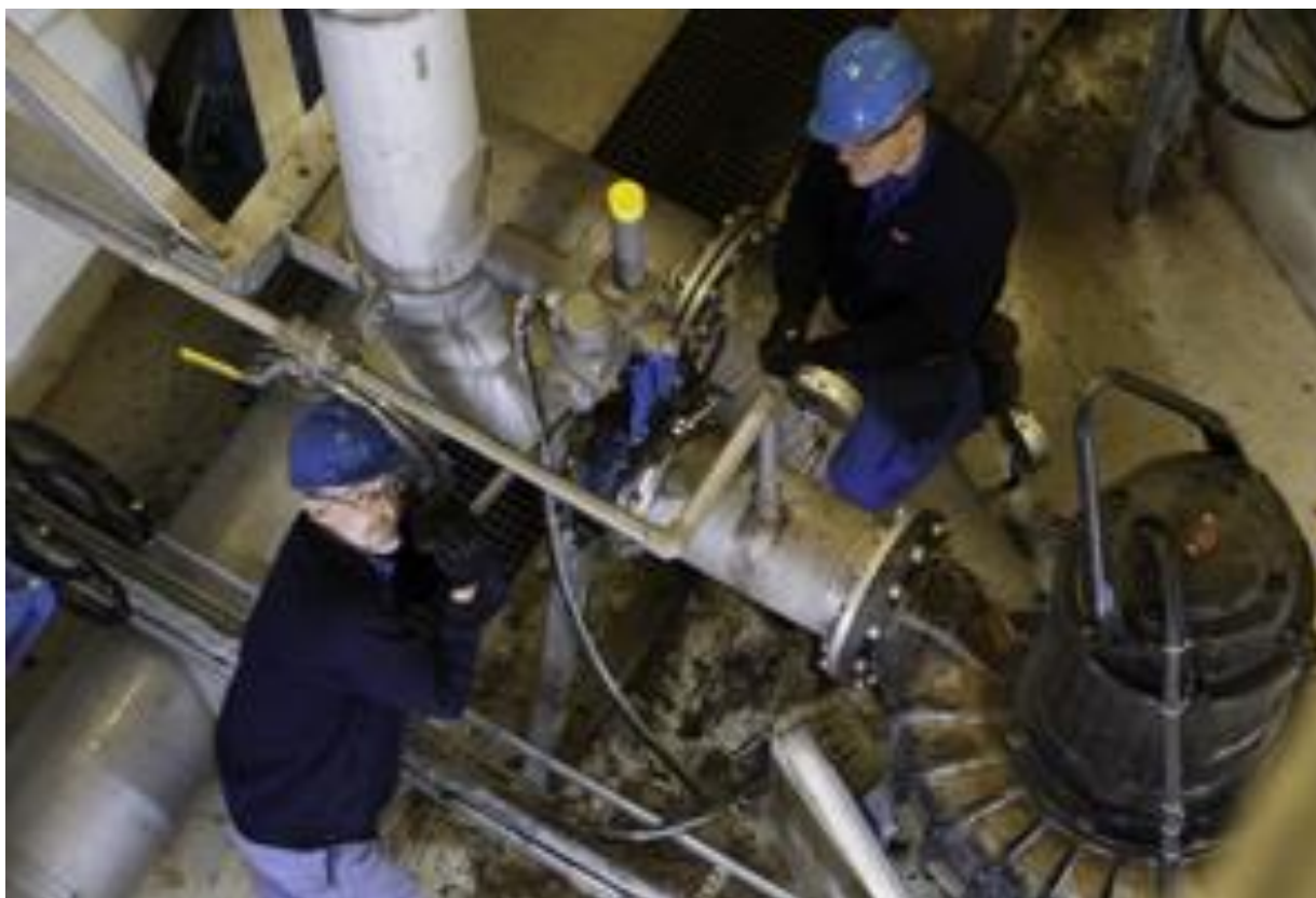
Vedligehold af pumpestation.
